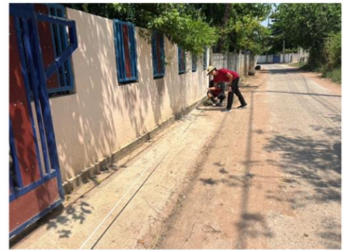
ภาพงานแล้วเสร็จ
