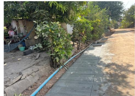
ภาพงานแล้วเสร็จ
