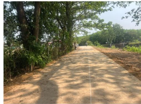
ภาพงานแล้วเสร็จ
