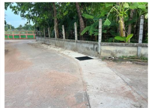
ภาพงานแล้วเสร็จ
