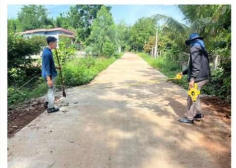
ภาพงานแล้วเสร็จ
