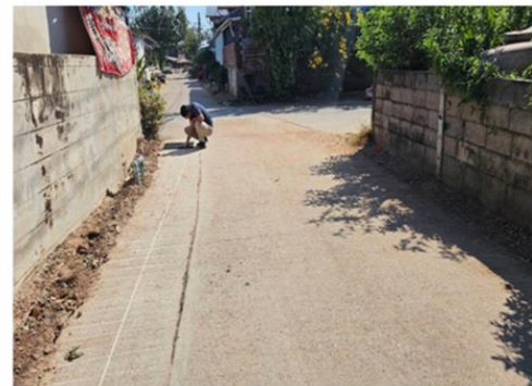
ภาพงานแล้วเสร็จ
