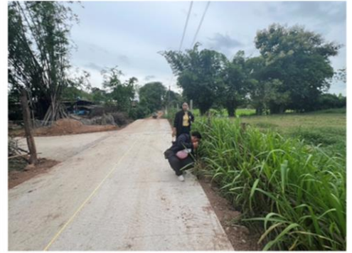
ภาพงานแล้วเสร็จ
