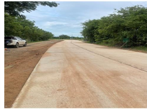
ภาพงานแล้วเสร็จ
