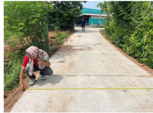
ภาพงานแล้วเสร็จ
