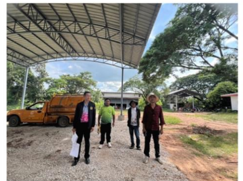
ภาพงานแล้วเสร็จ
