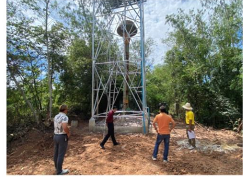
ภาพงานแล้วเสร็จ
