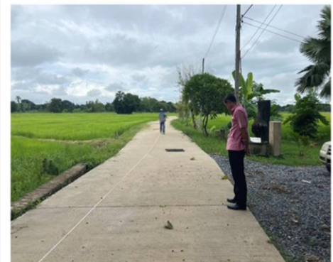
ภาพงานแล้วเสร็จ
