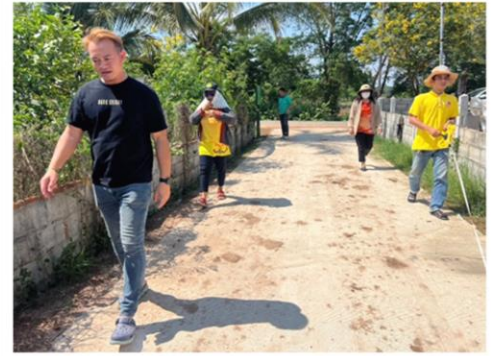
ภาพงานแล้วเสร็จ
