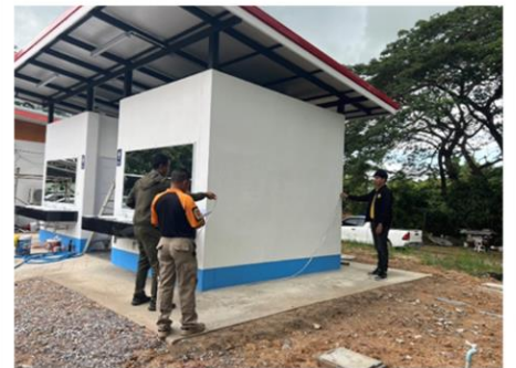
ภาพงานแล้วเสร็จ
