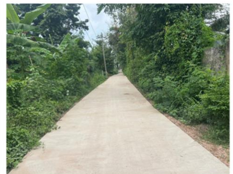
ภาพงานแล้วเสร็จ
