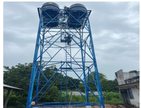
ภาพงานแล้วเสร็จ
