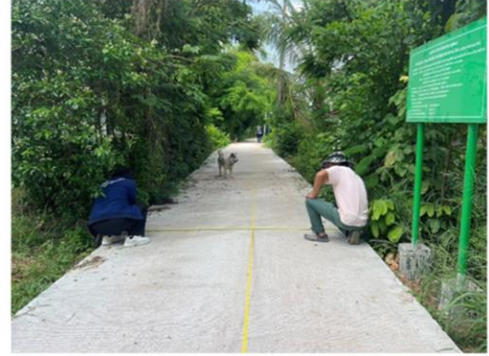
ภาพงานแล้วเสร็จ
