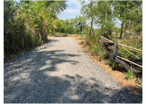
ภาพงานแล้วเสร็จ
