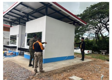
ภาพงานแล้วเสร็จ
