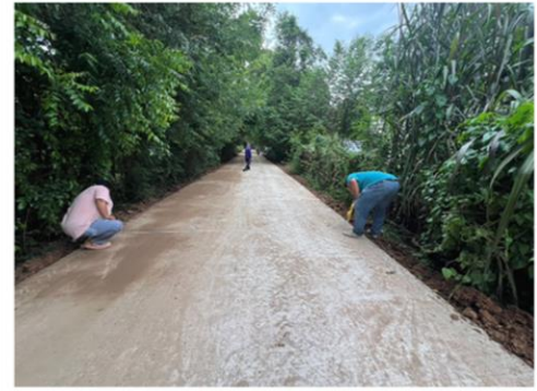
ภาพงานแล้วเสร็จ
