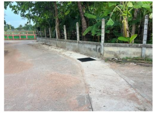
ภาพงานแล้วเสร็จ
