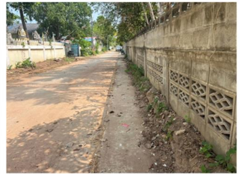
ภาพงานแล้วเสร็จ
