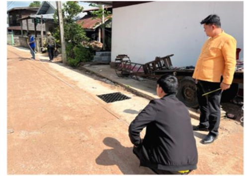
ภาพงานแล้วเสร็จ
