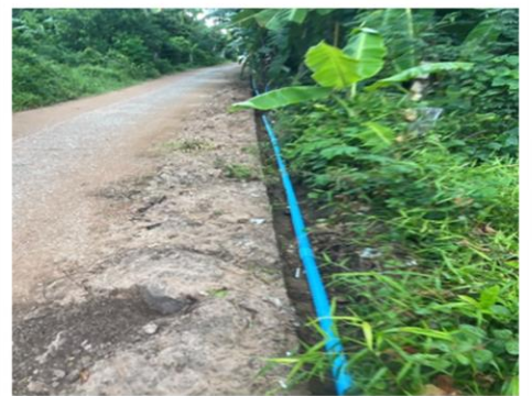
ภาพงานแล้วเสร็จ
