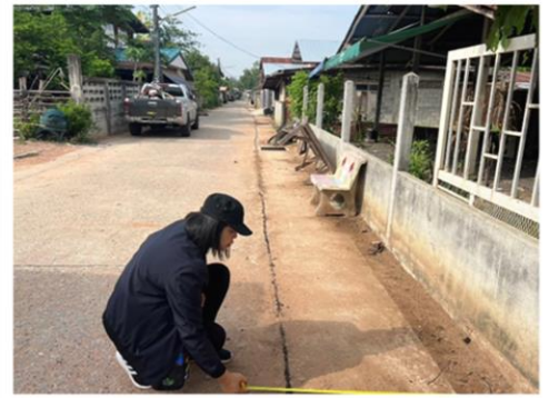
ภาพงานแล้วเสร็จ
