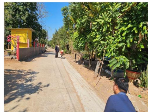
ภาพงานแล้วเสร็จ
