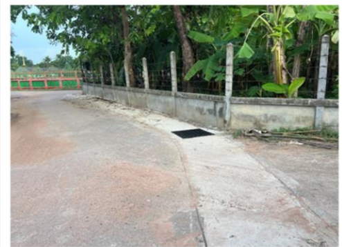
ภาพงานแล้วเสร็จ
