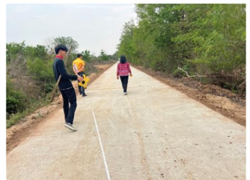
ภาพงานแล้วเสร็จ
