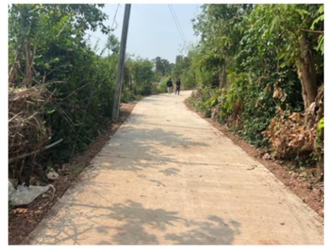
ภาพงานแล้วเสร็จ
