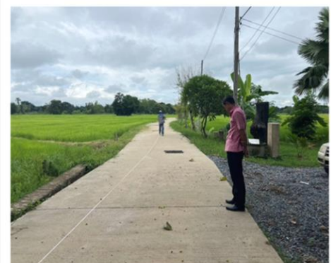
ภาพงานแล้วเสร็จ
