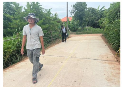
ภาพงานแล้วเสร็จ
