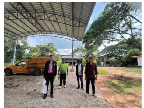
ภาพงานแล้วเสร็จ
