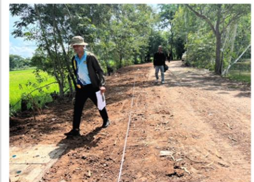
ภาพงานแล้วเสร็จ
