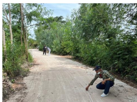
ภาพงานแล้วเสร็จ
