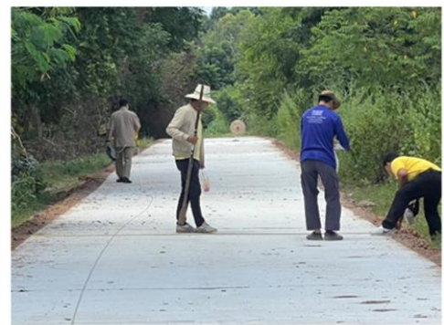
ภาพงานแล้วเสร็จ
