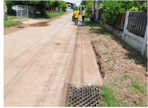
ภาพงานแล้วเสร็จ
