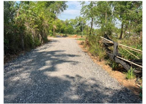
ภาพงานแล้วเสร็จ
