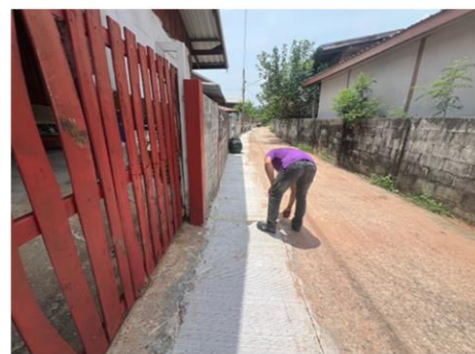
ภาพงานแล้วเสร็จ
